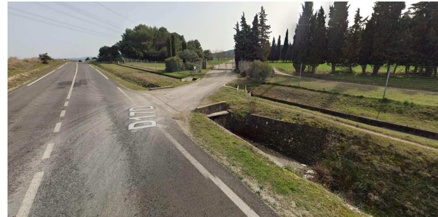
Accès au site depuis la D17D / Source : google earth
