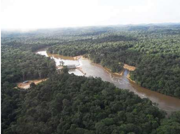
Centrale hydroélectrique – Source : VOLTALIA
