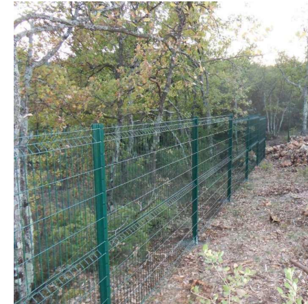
Exemple de clôture sans bavolet – Parc solaire de Montmayon - VOLTALIA
